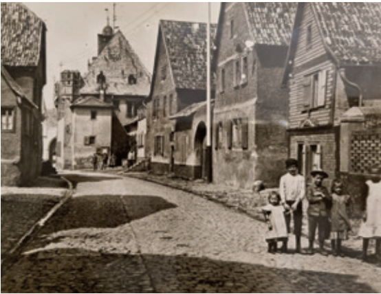
Die Rathausstraße Anfang des 20. Jahrhunderts. Das zweite Haus von rechts oberhalb des Rathauses zeigt das Bermann'sche Anwesen. Foto: Sammlung Klaus Leitsch
